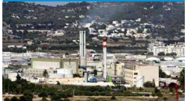
Central térmica GESA
