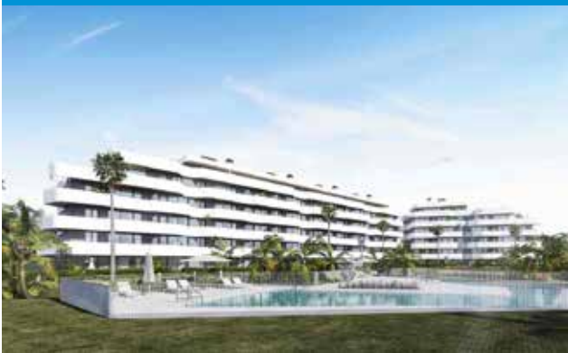
70 viviendas La Cizaña
